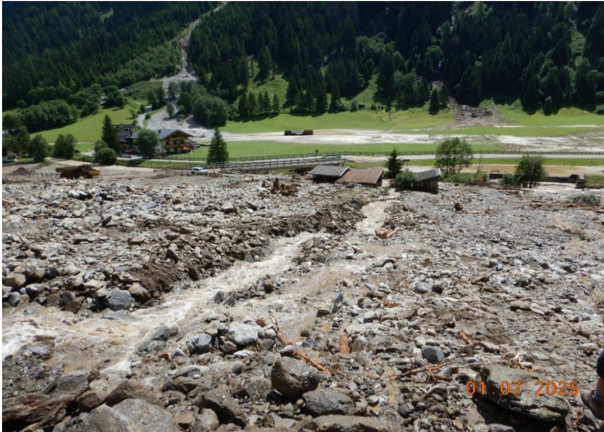
Abbildung 30: Alfeierbach, Schwemmkegel mit beschädigten Wirtschaftsgebäuden, 1.7.2025
