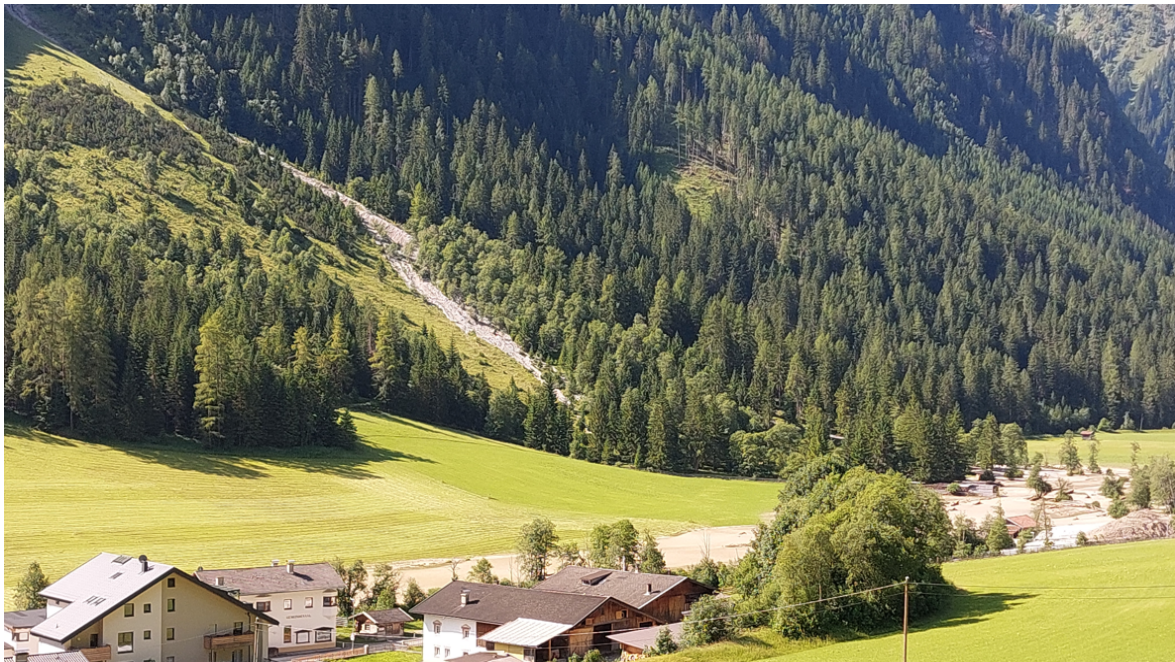
Abbildung 43: Kreitherbach, Unterlauf, Austrittsstelle und Schwemmkegel 1.7.2025
