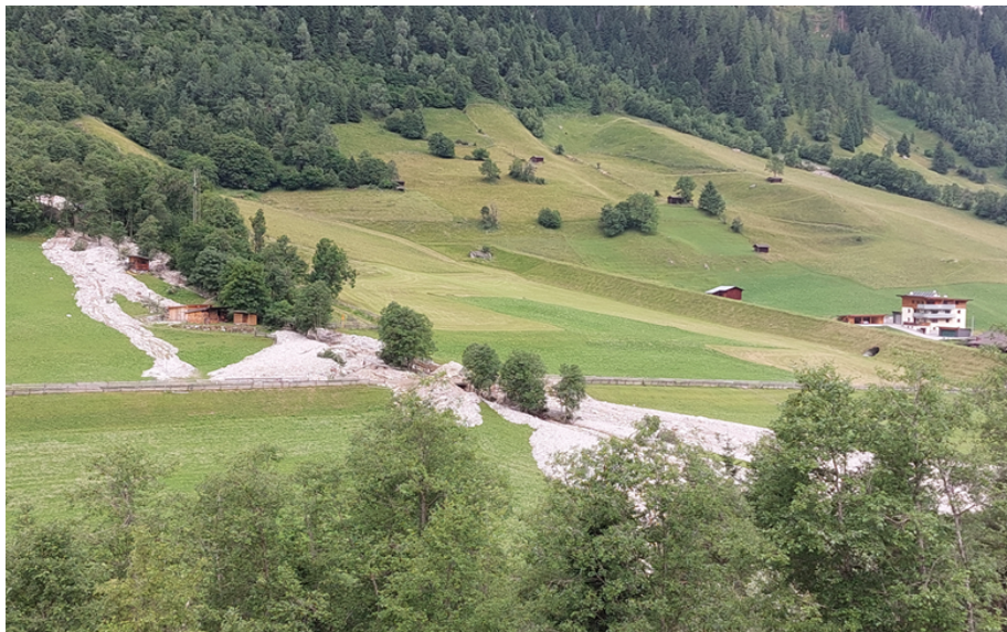
Abbildung 56: Gurnsbach, Unterlauf, Ausbruchsstelle, Geschiebeablagerungen und beschädigte Wirtschaftsgebäude
