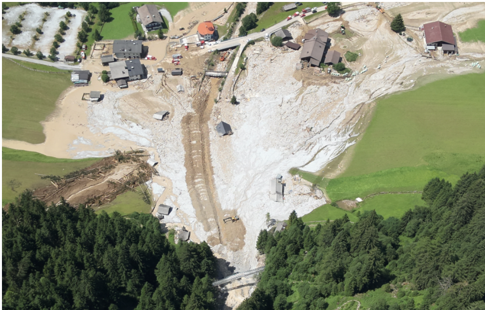
Abbildung 19: Sandesbach, Schwemmkegel mit zerstörtem Mühldorf
