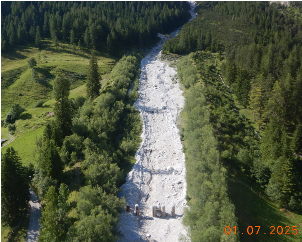
Abbildung 52: Gänsebach, beschädigter Murbrecher, 1.7.2025
