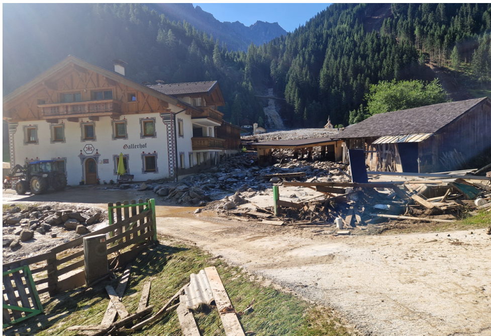
Abbildung 21: Sandesbach, stark beschädigtes Hotel und Nebengebäude
