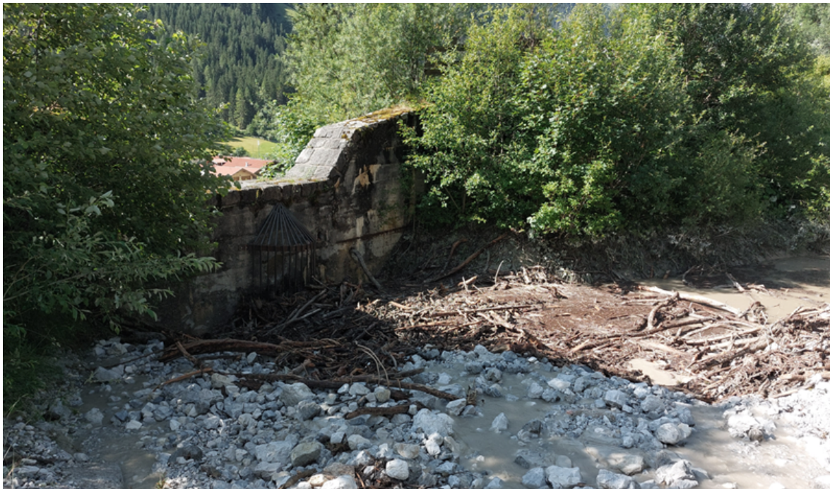
Abbildung 62: Teilverfüllung des Geschieberetentionsbeckens
