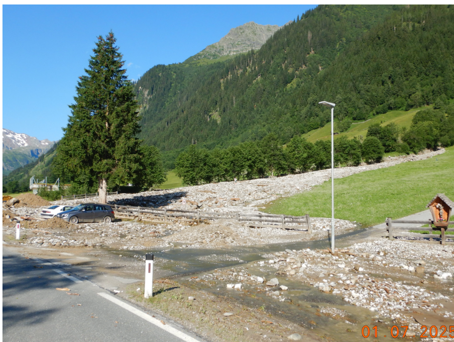
Abbildung 45: Kreitherbach, Schwemmkegel, beschädigte KFZs, 1.7.2025
