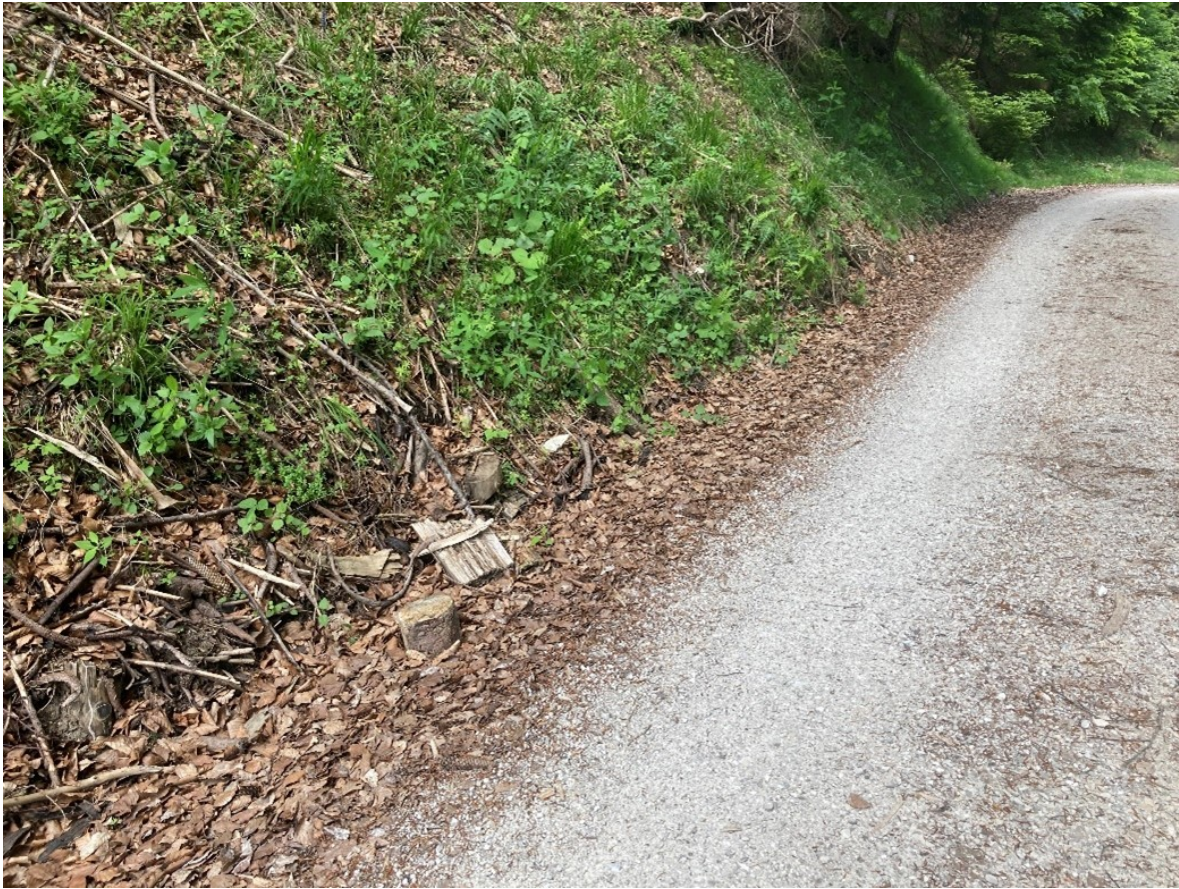
Abbildung 30 Beispiel für die Dokumentation der Gestaltung und Zustand der Längsentwässerung entlang der erhobenen Straßenabschnitte
