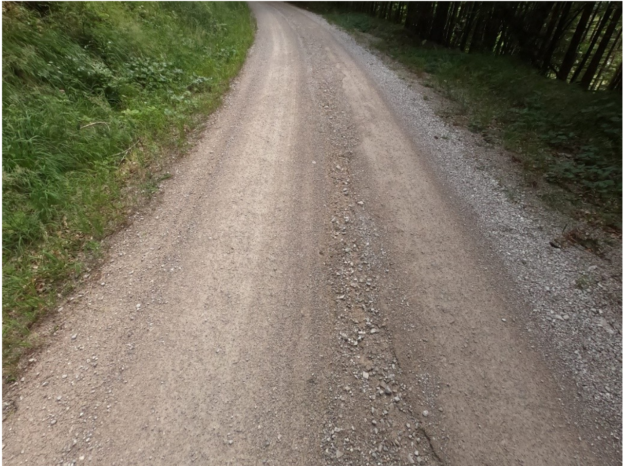
Abbildung 58 Originalbild von den in Summe 25.300 Bildern umfassende photogrammetrische Aufnahme mit klar erkennbarem Zustand der Forststraße inklusive Oberflächenabfluss und Längsentwässerung
