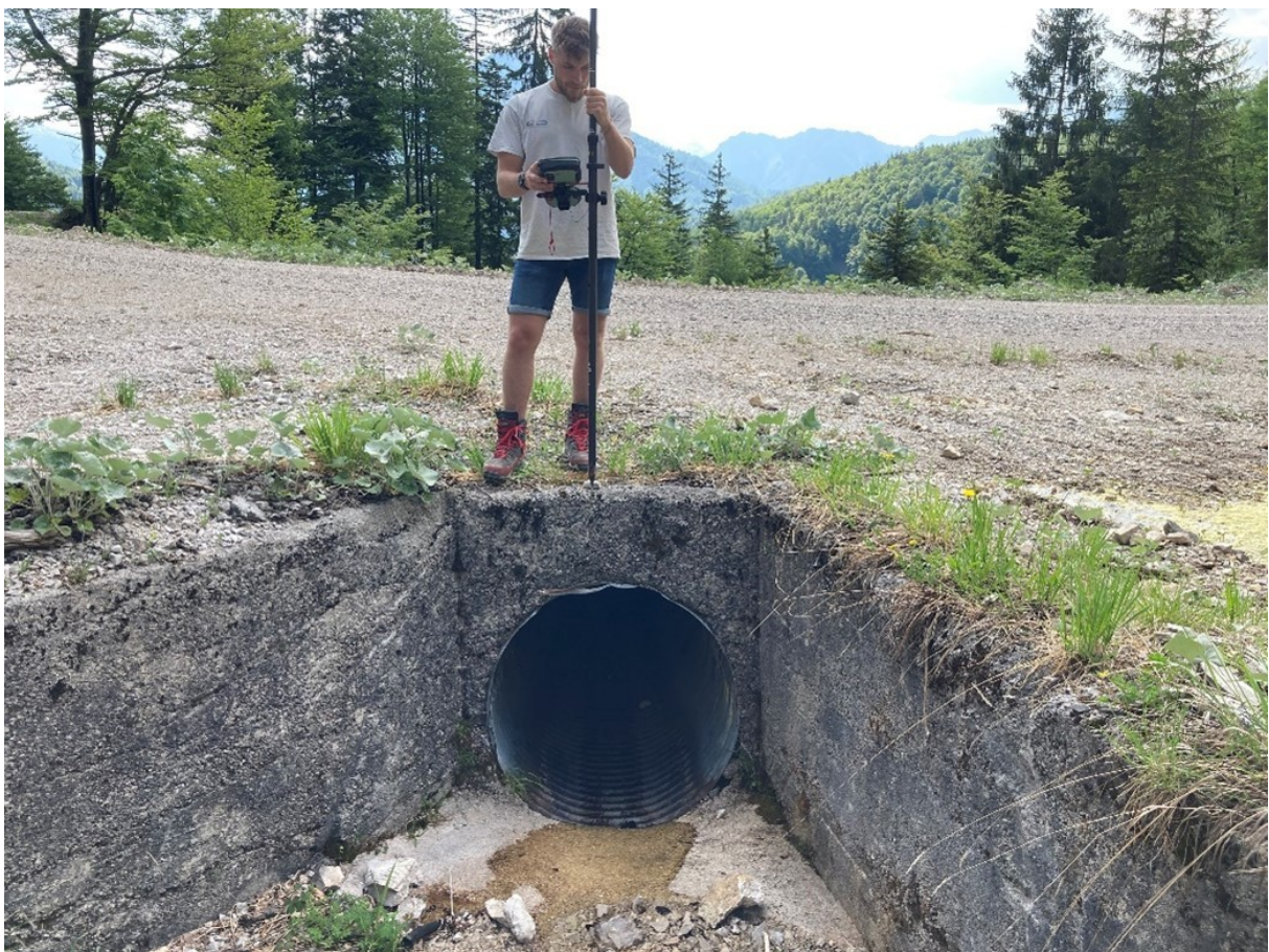
Abbildung 28 Erfassung eines Rohrdurchlasses mit Leica GS18 GNSS-RTK-Rover in Kombination mit dem Leica CS20 Feld-Controller und Leica Captivate (RTK-Einheit)
